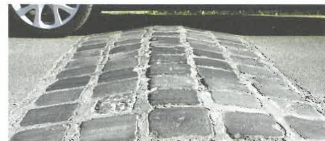
■ NEM AZ IGAZI... – Betonba ágyazott nagykockakő burkolat, ami túl azon, hogy költséges, beépítésekor az útpálya szerkezetét is meg kell bontani
