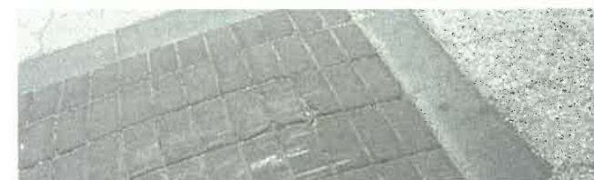
■ NEM MINDIG LÁTN – A fotón egy térkő burkolat látható meredek felvezetéssel. Sötétben, vagy ha rosszak a látási viszonyok, késő észlelhetjük a „fekvőrendőrt”, így előfordulhat, hogy ráhajtáskor megsérül az autó alváza is
