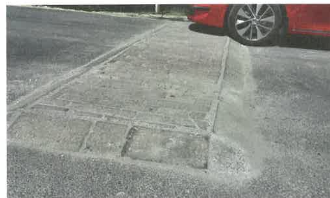
■ BETONBA ÁGYAZOTT TÉRKŐ BURKOLAT MEREDEK FELHAJTÓVAL – Egy-egy találkozás komoly károkat okozhat a gépjármű felfüggesztésében is...
