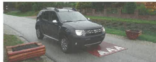
■ VIRÁGLÁDA – Egy sebességcsillapító párna alkalmazása esetén padkára hajtás elleni védelem elhelyezése javasolt
